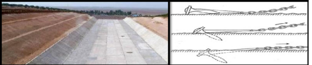
Resim 10. Kanal beton kaplaması ve demir atma
